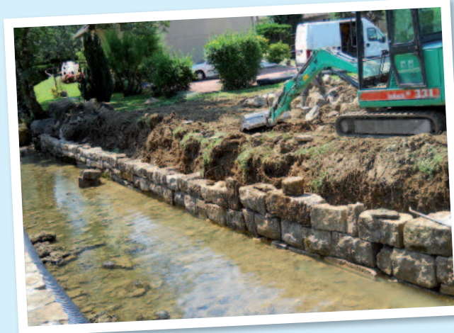
Réfection de mur le long du Savignard à "La Tournerie"
