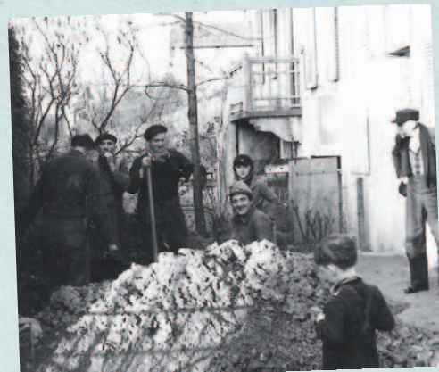
Travaux de captage de la source par un groupe d'habitants de la Fontaine Odin
