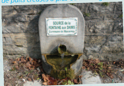
De nos jours : l'arrivée d'eau au bord de la route. C'est ici qu'il n'y a pas si longtemps encore en 1959, les ménagères faisaient la lessive
